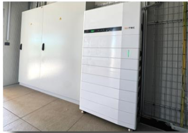
Batteriespeicher & Wechselrichter
