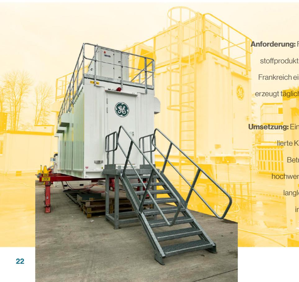
*/// Durch eine parallele Fertigungsmethode konnten mehrere Arbeitsschritte gleichzeitig ausgeführt werden: Während im Haubenbereich die Elektro-, Klima- und Stromsysteme installiert wurden, erfolgte zeitgleich die Integration von Schaltanlagen, Verkabelung und Bodeninstallationen. Anschließend wurden Haube und Boden zu einer stabilen Einheit verbunden, um die mechanische Stabilität und Betriebssicherheit zu gewährleisten.*
